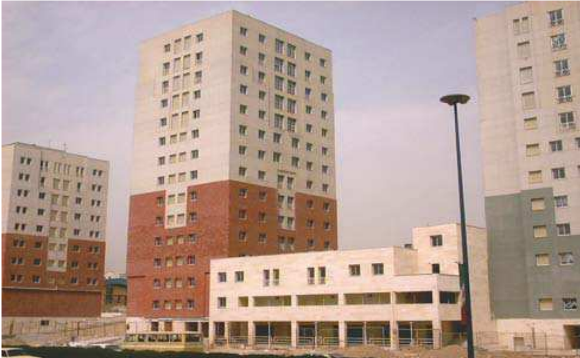
Photo 20 : Les espaces abandonnés et vacants derrière les nouveaux immeubles entre l'ancien tissu urbain qui attire les délinquances.
