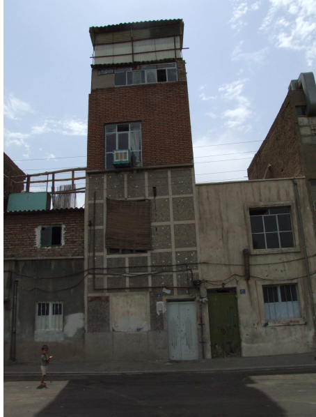
Photo 5 : Rajout d'étages dans les petits lotissements ayant une largeur de moins de 4m. Ce type de construction pour répondre aux besoins de logements ne dispose pas les normes suffisantes et de qualité augmentant ainsi le niveau de la vulnérabilité (Le 20ème arr. au sud de Téhéran, 2006)
