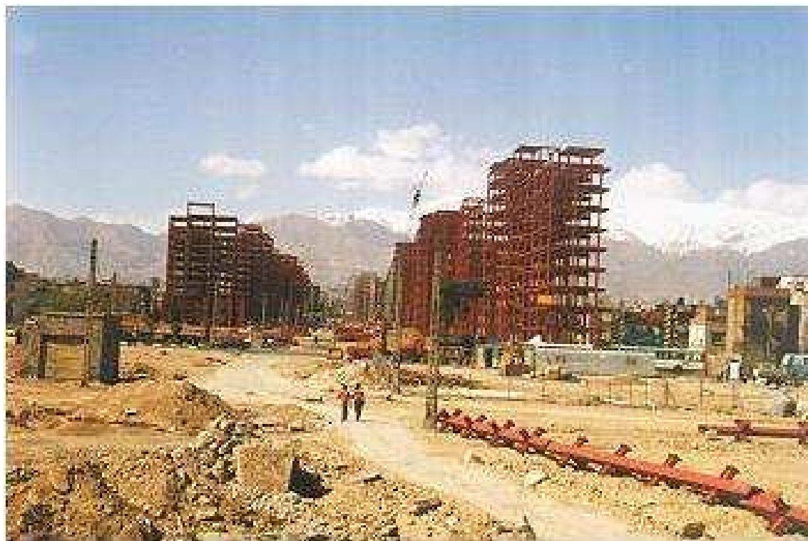
Photo 13 : Début de la construction de la 1 ère phase de Nawab (Source: Archive de l'ORUT)
