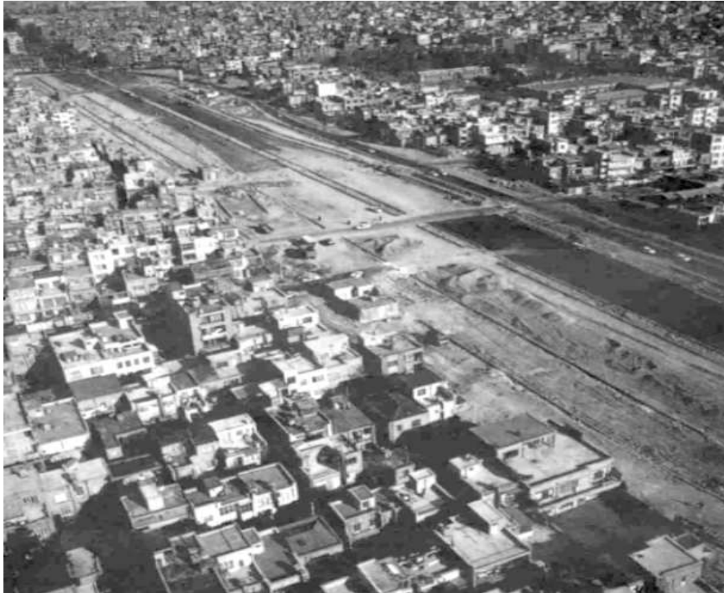
Photo 12 : Une vue de la démolition et le rasage des sites de projet Navab (Source: Bahrainy, S. H., 2007)
